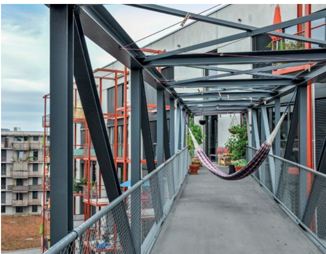
Abb. 57: Brücke zwischen den Gebäuden im 5.OG
