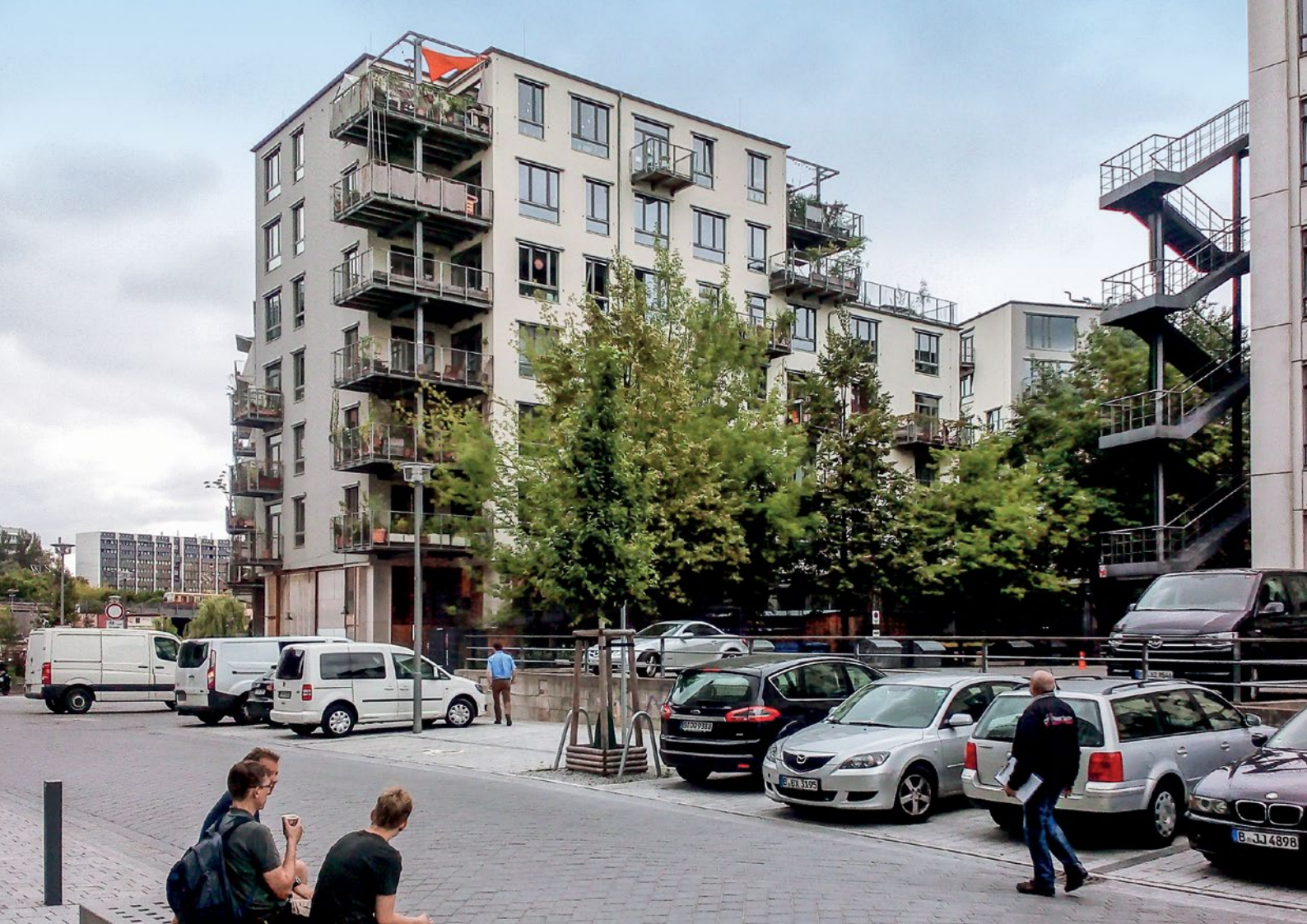
Abb. 8: Spreefeld Straßenseite, Blick auf Haus 2
