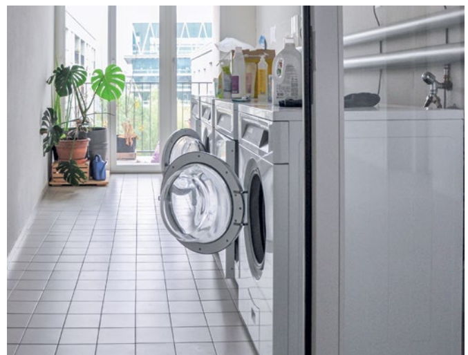
Abb. 24: Gemeinsam genutzte Waschküche auf jeder Etage
