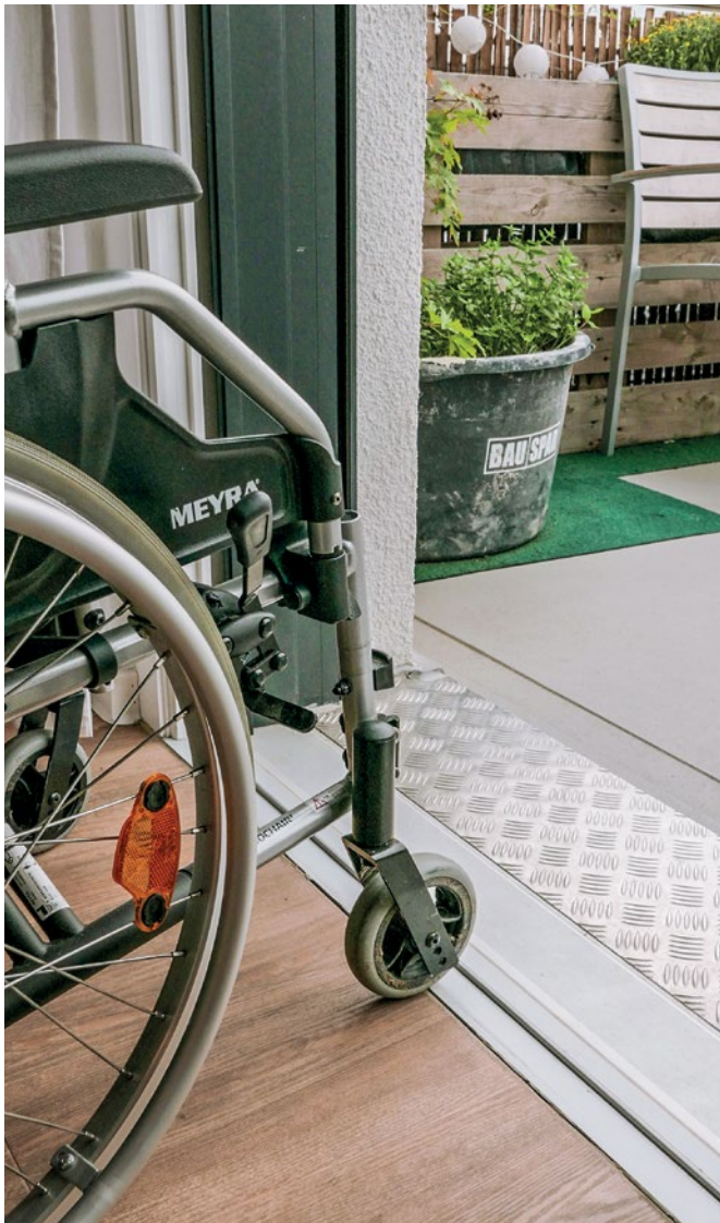
Abb. 68: Schwellenloser Übergang
